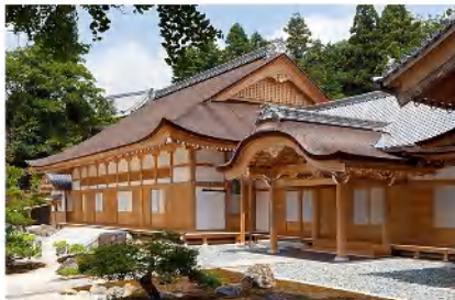
岐阜県 永保寺本堂外観
