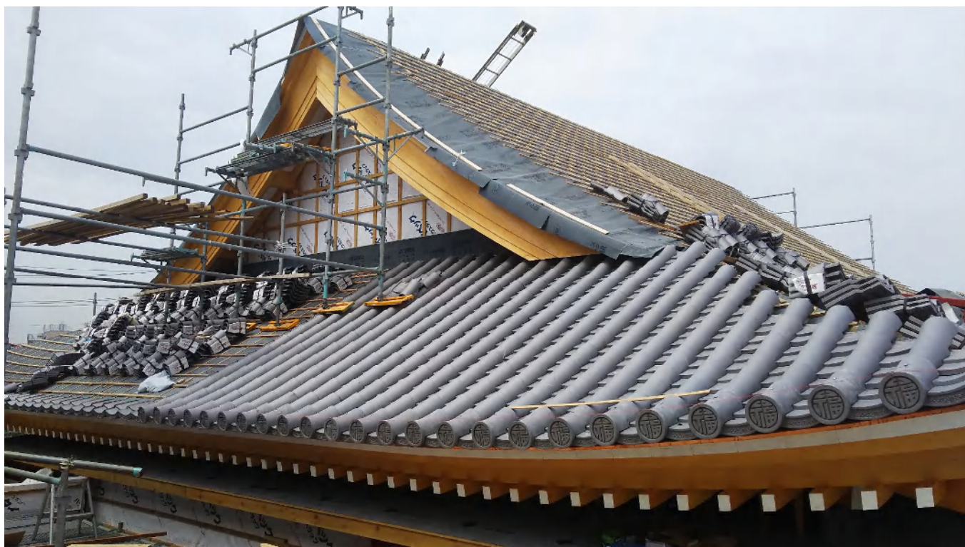
庫裡と同時に、本堂の本葺き瓦の工事もはじまりました。
