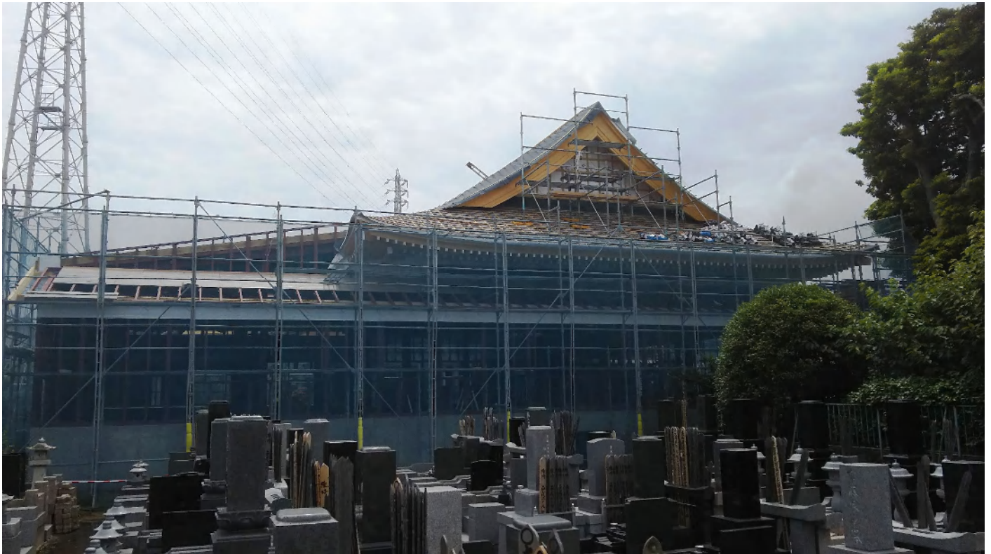
【お墓側から見た工事途中の様子。】 屋根のそり具合や本堂西側の長い廊下が創 造できます。
