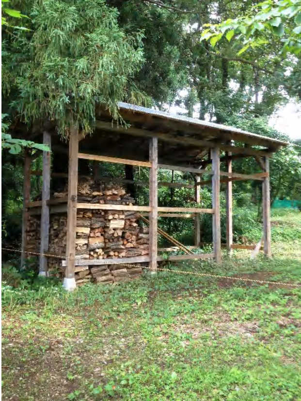
住職手作りの薪小屋(建築廃材でできています。)
