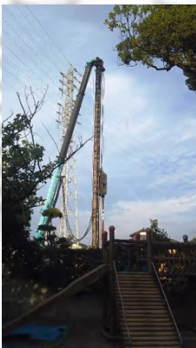
基礎杭打ちの様子
